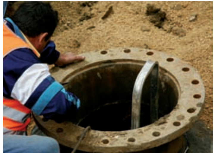
Una de las obras de mejora de Acosol en la ciudad. La Tribuna
